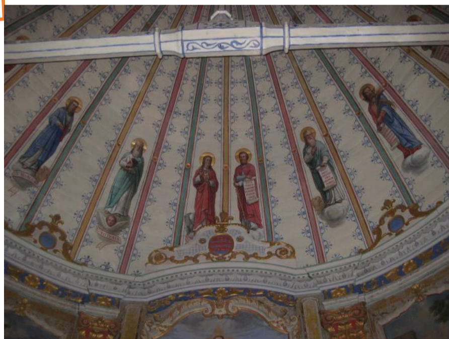
Église de Saint-Germain-de-la-Coudre, voûte du chœur restaurée
