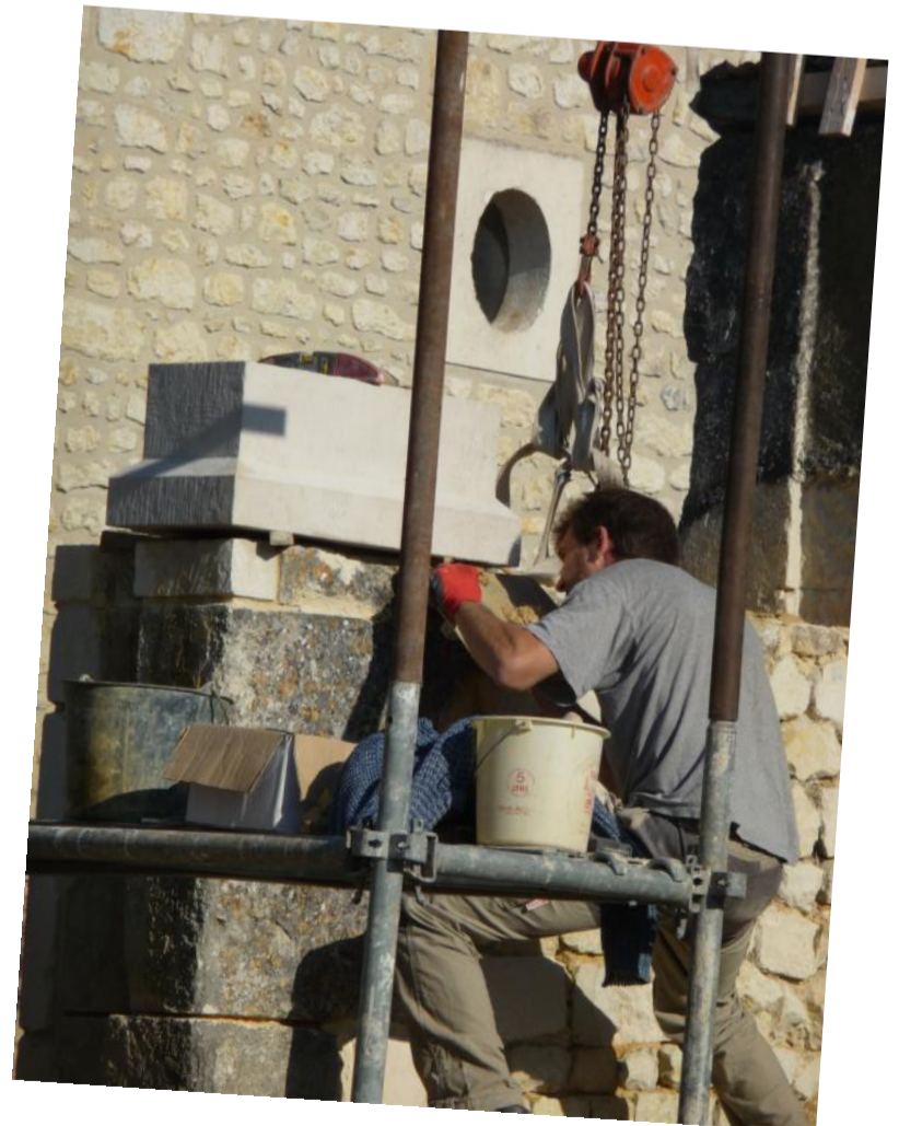
Pose d'un couronnement de portail à Réveillon
